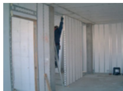
Avvitatura sugli angolari dei pannelli Divisori Plastbau
