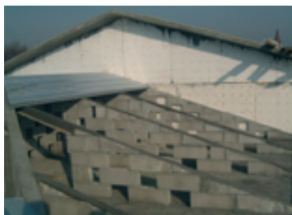
adattamento e posa pannelli sui muretti
